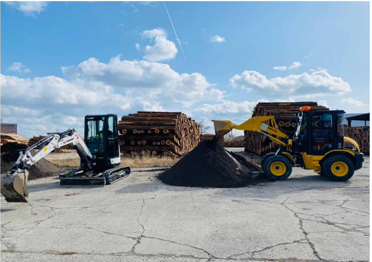
小型重機操作訓練
